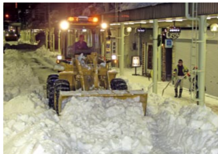
夜間の除雪作業。豪雪時の費用は年間30億円にもなる
