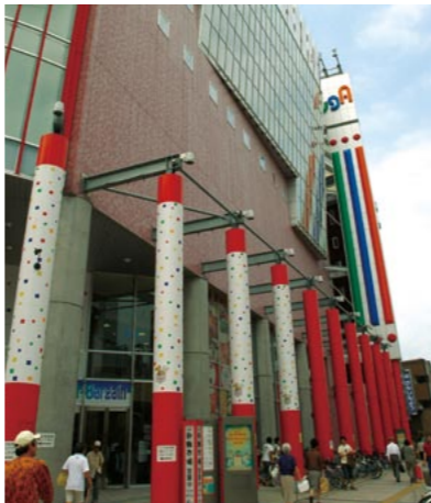
複合施設「アウガ」。年間600万人を越える利用者を集めている
