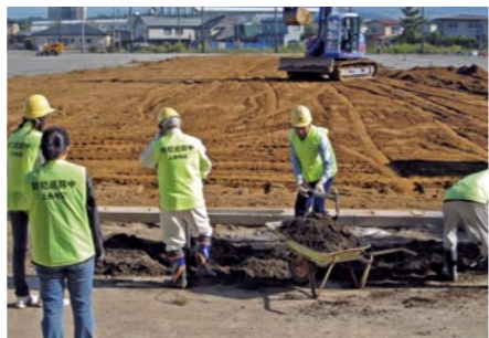
住民自らで水はけ工事を行った中学校の校庭
