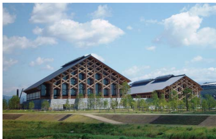
愛媛県武道館。県内産の木材を屋根架構や柱材に使用
