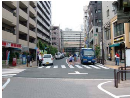
かつての京王線明大前駅周辺(上)と整備後(下)
