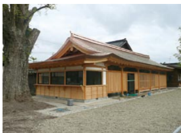
勝興寺の公衆トイレ。銅版を葺き、地元の木材を使うなどして景観を損ねないようにした。機能面では特に女性に配慮。スペースを広くしたり、ショルダーバックをかける場所を設置している
