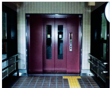
バリアフリー化した阪急逆瀬川駅エレベーター
