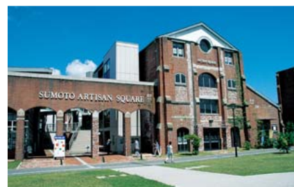
洲本市民工房(外観)
