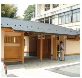
役場庁舎横の公衆トイレは多目的トイレに改修された
