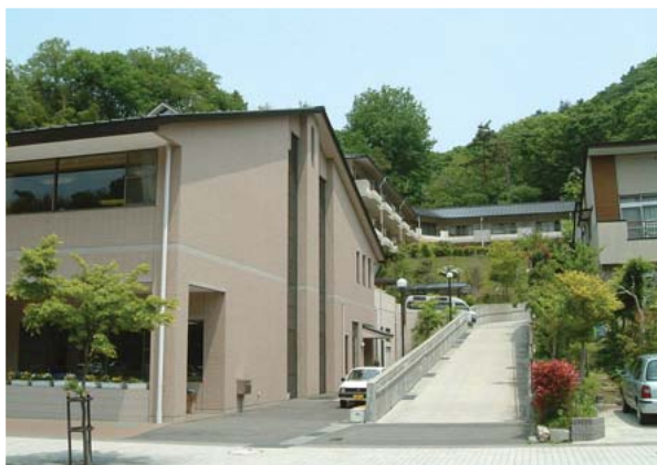
手前の「福祉会館」のエレベータを使って、丘の上の高齢者住宅にアクセスできる
