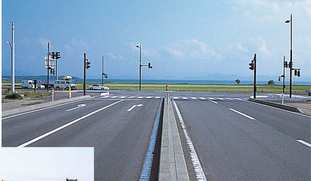
猪苗代湖の眺望を妨げていた電線類を電力会社や電話会社の協力により地中化
