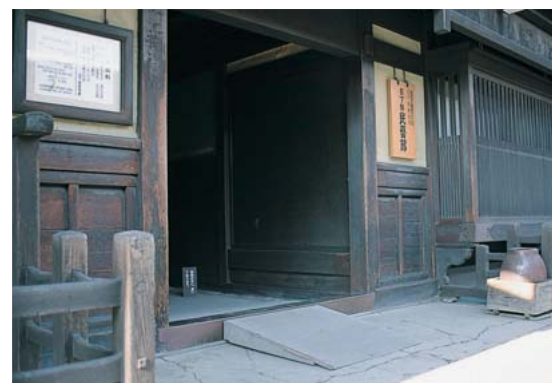
入り口に仮設のスロープを設置した重文指定の「日下部民芸館」
