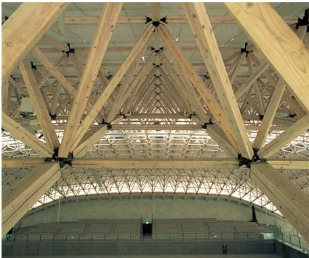
日本初の木造トラスト工法で造られた小国ドーム
