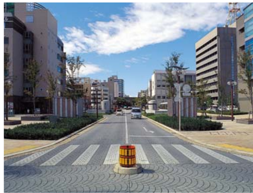
車歩道の段差を少なくしたことで、広々とした都市空間を演出
