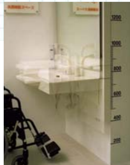
車いす対応洗面カウンターの高さ検証機能
